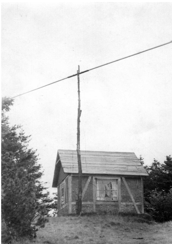
Figur 4.6: (1956) Klubbens sommer QTH ved Toftum Bjerge med den foldede 20 m dipol.
